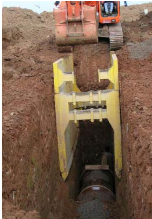
Esempio armatura per sostegno pareti di scavi a trincea
